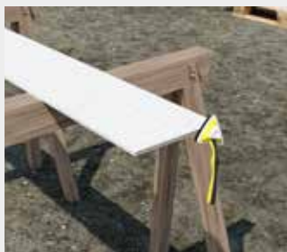
Uzklāj ColourPlus TM malu pārklājumu pirms uzstādīšanas.
