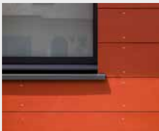
Horizontālā uzstādīšana ar atvērtu šuvi.
