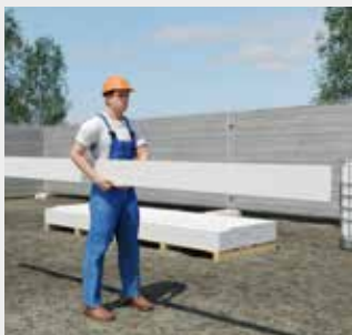
HardiePlank ® dēļus uzstādot, vienmēr pārnēsāt vertikāli.
