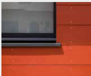
Horizontālā uzstādīšana ar atvērtu šuvi.
