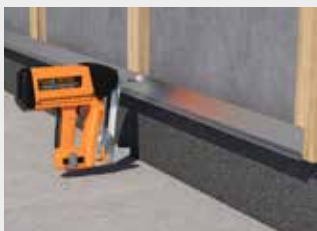
Cokola ventilācijas profila piestiprināšana.
