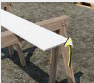
Uzklāj ColourPlus TM malu pārklājumu pirms uzstādīšanas.
